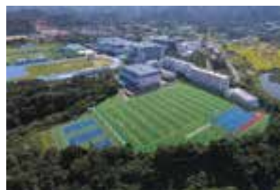
令和5(2023)年3月完成。人工芝グラウンド
